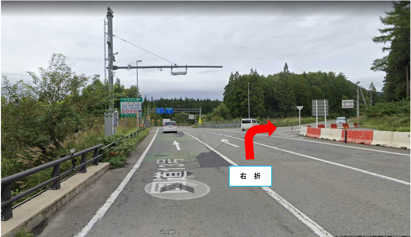
写真③ 金山ICを右折してそのまま国道13号を進む（釜淵/町内中田の表示）
