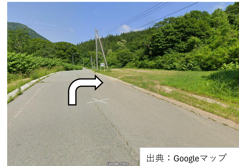
写真④ 柳沢山元土場（第5駐車場）
